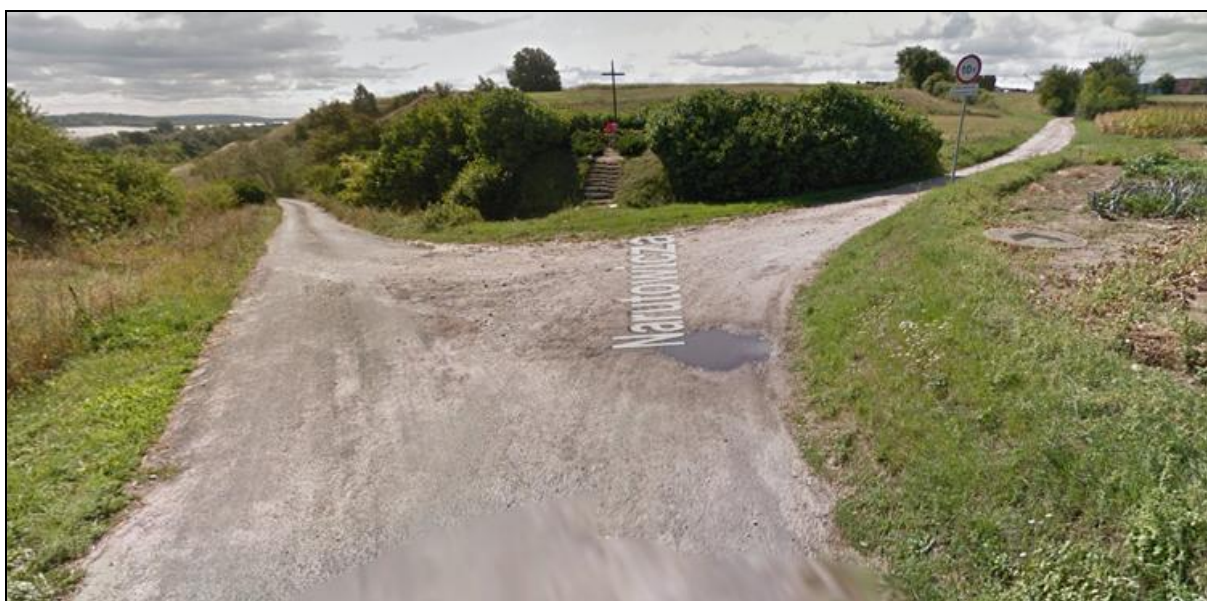
Rysunek 9. Droga gminna w miejscowości Przepust
